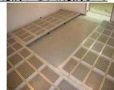
※ 従来冷蔵プレハブを氷感庫に改造することができ運用に合わせ様々なタイプを改造可能。例えば、果物など見た目を大切にしたいものは柵方式、大量保管するものはフォークリフトも利用可能な架台やパレトラック方式を選択できる。
